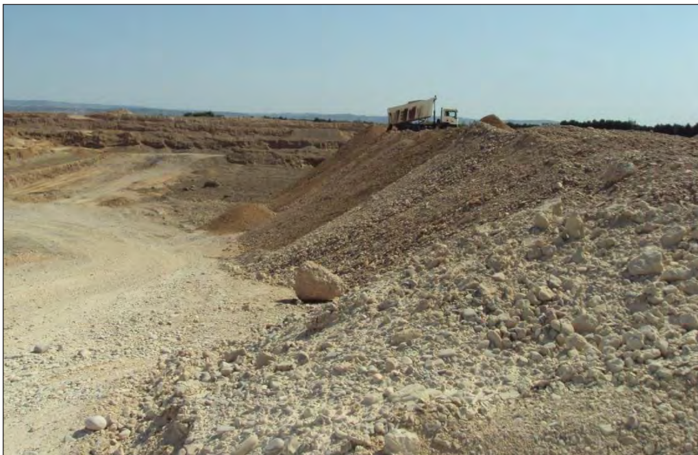
Fotografía.2- Modelo del relleno tras la explotación hasta la cota diseñada.
